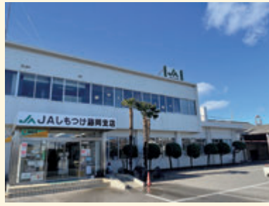
樹木の剪定作業を終え、きれいになった藤岡支店外観
